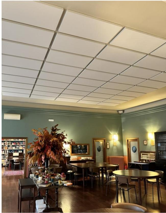
**Fig. 22 Particolare della sala ristorante a valle degli interventi di correzione acustica**
