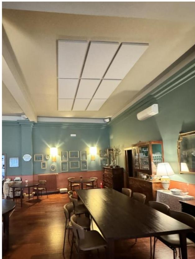
**Fig. 25 Particolare della sala ristorante a valle degli interventi di correzione acustica**
