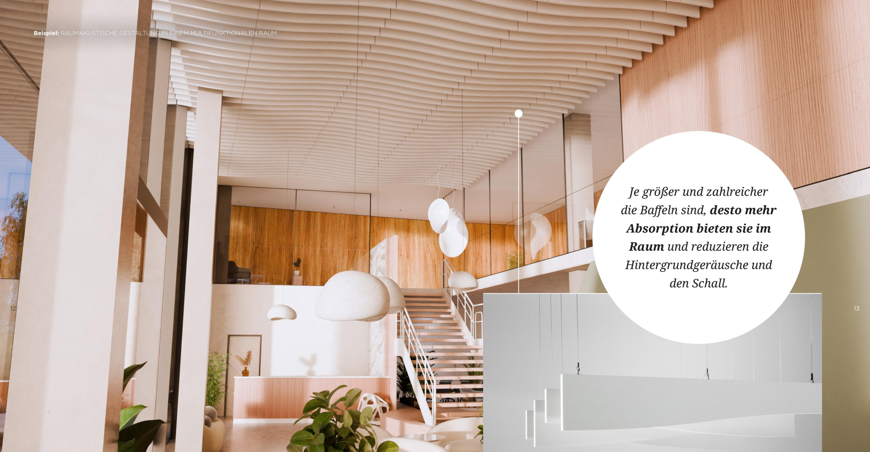
*Je größer und zahlreicher die Baffeln sind, desto mehr Absorption bieten sie im Raum und reduzieren die Hintergrundgeräusche und den Schall.*
