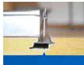
Sección de Focus Ds instalado con Connect Bridging
