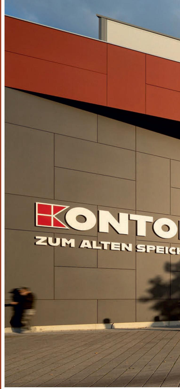
Das Kontor selbst erfuhr auf Grundlage des Entwurfs der archis Architekten + Ingenieure GmbH eine umfassende Sanierung: Äußerlich stellten sie der bestehenden Gebäudehülle eine neue Fassade aus Faserzementplatten voran, die postmodern anmutet, in ihrem rotbraunen Farbton aber gleichzeitig an die typisch norddeutsche Backsteinarchitektur erinnert. Innerlich folgt die Gestaltung hingegen dem süd-
