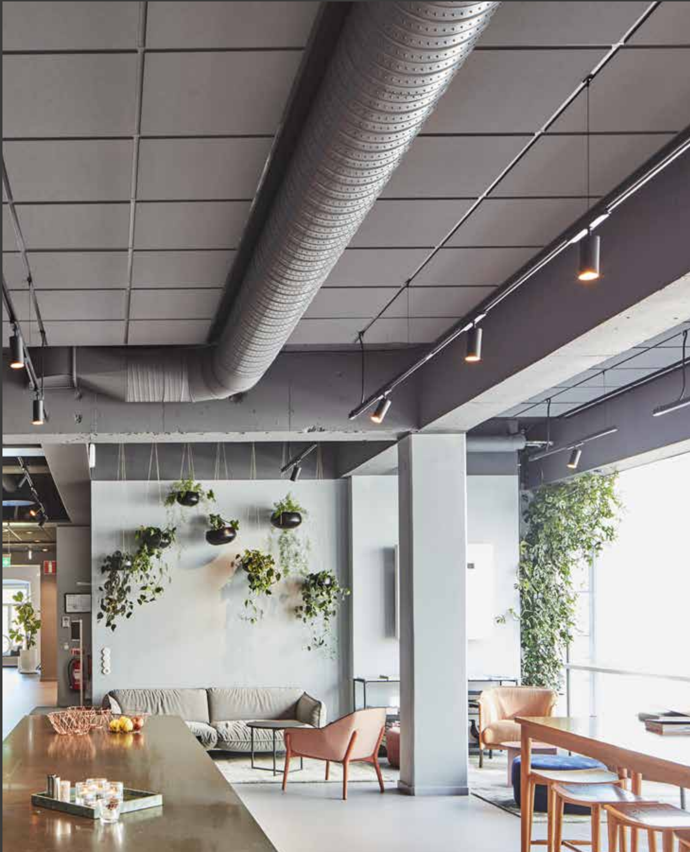
FOCUS E Nedhængt synligt skinneresystem skaber en skyggeeffekt på kanten. Let demonterbare plader.
