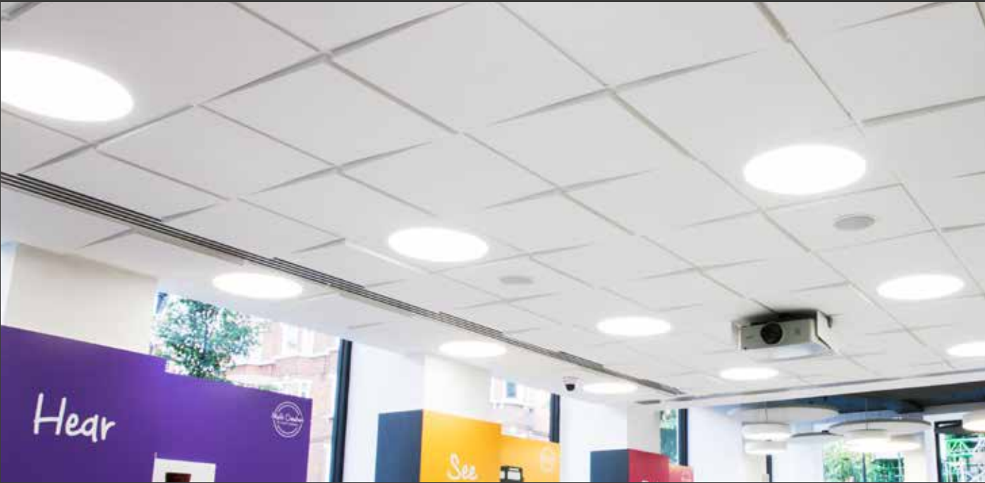
DOT Et fuldt integreret armatur med cirkelformet lysåbning. Fremragende lyskomfort og lav UGR-værdi.
