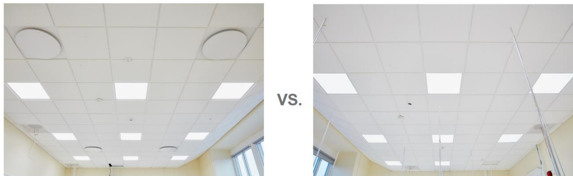
Fig.2 – Techo de las aulas con sistema de climatización tradicional (izquierda) y con climatización difusa (derecha).
